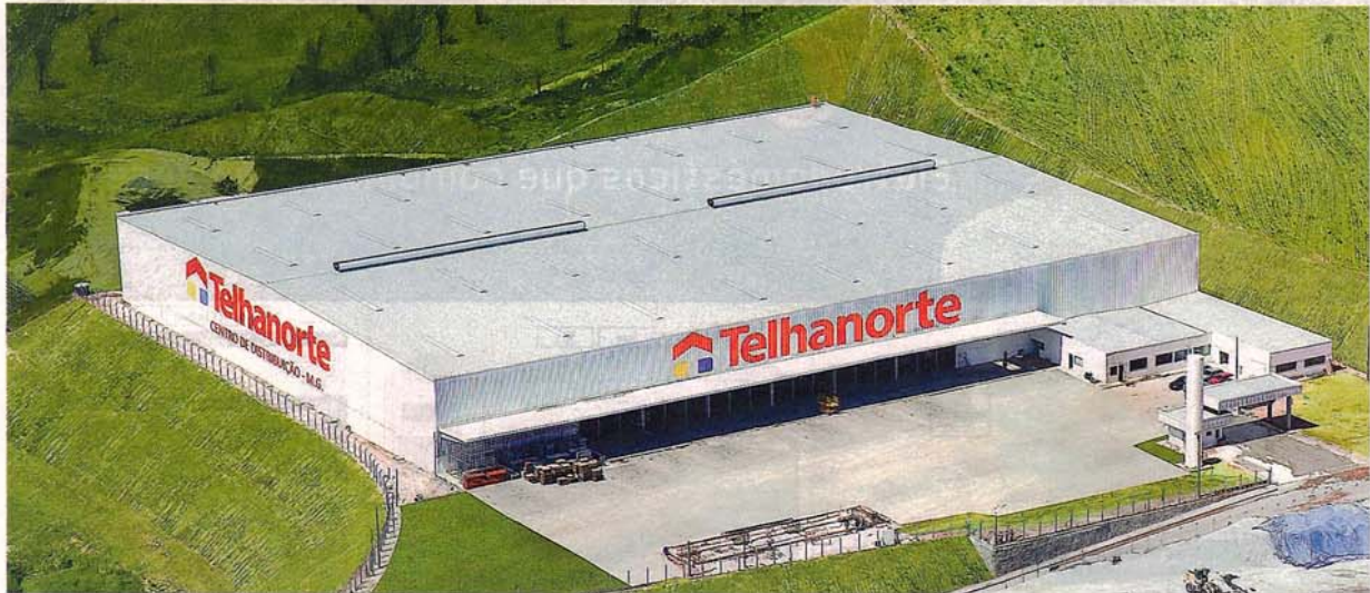
Centro de Distribuição da Telhanorte em Ribeirão das Neves
